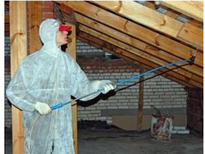
Обробка дерев'яних конструкцій вогнетривкою сумішшю
