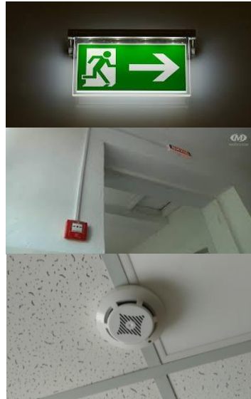
Сучасна автоматична пожежна сигналізація підключена до пульта управління ДСНС
